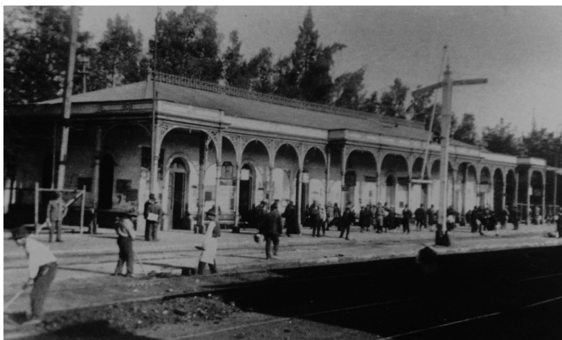
Figura 1: Estación de Ferrocarriles de San Bernardo
