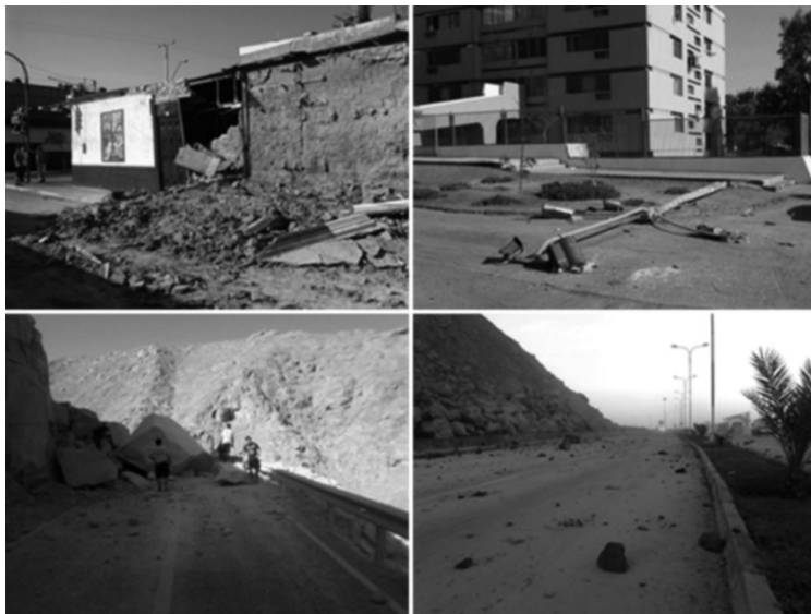
Figura 9 Daños provocados por el terremoto del 1 de abril de 2014, en la ciudad de Arica
