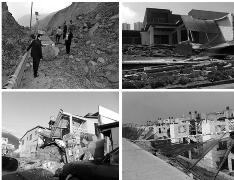
Figura 10 Daños provocados por el terremoto del 1 de abril de 2014, en la ciudad de Iquique
